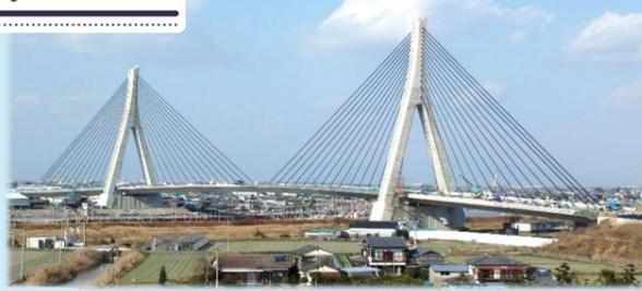
中央支間長は261m、斜材は一面吊り、主塔は逆Y型のPC斜張橋で、国内最大クラス。長大斜張橋では稀な曲線斜張橋。
